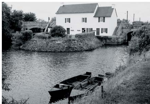
Maison de l'éclusier (Saint-Malo-de-Guersac)
